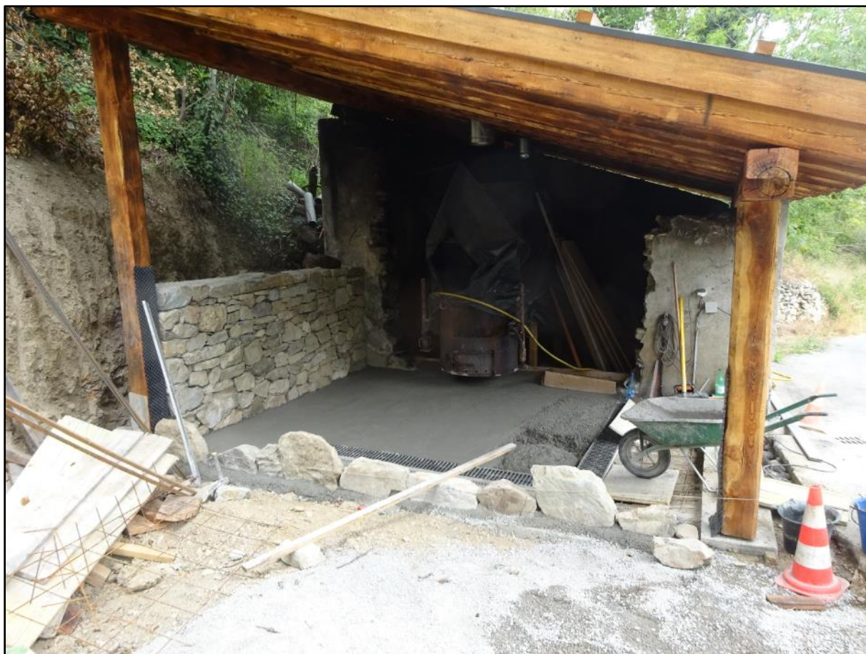
Image 78 : réalisation de la dalle
