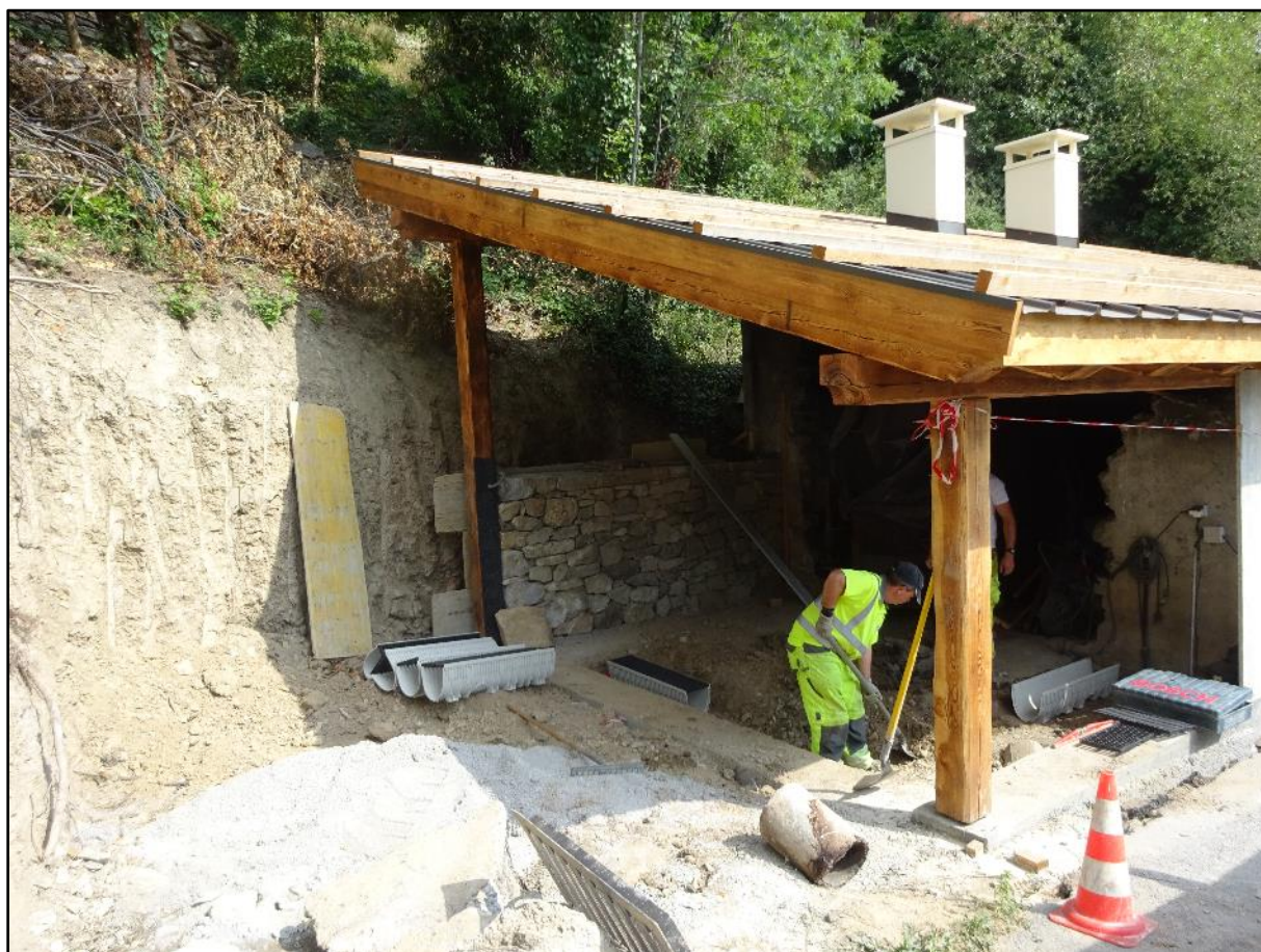
Image 74 : préparation de la dalle
