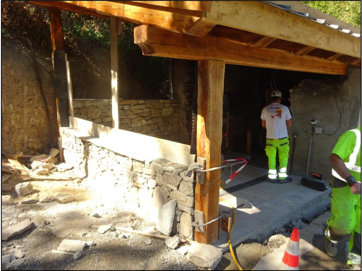
Image 79 : début de la réalisation du second mur
