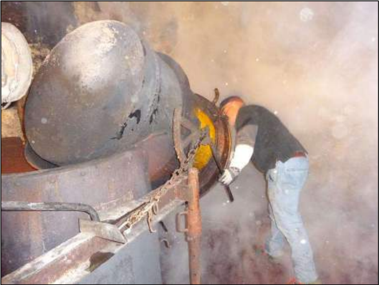
Image 29 : vérification avant nettoyage
