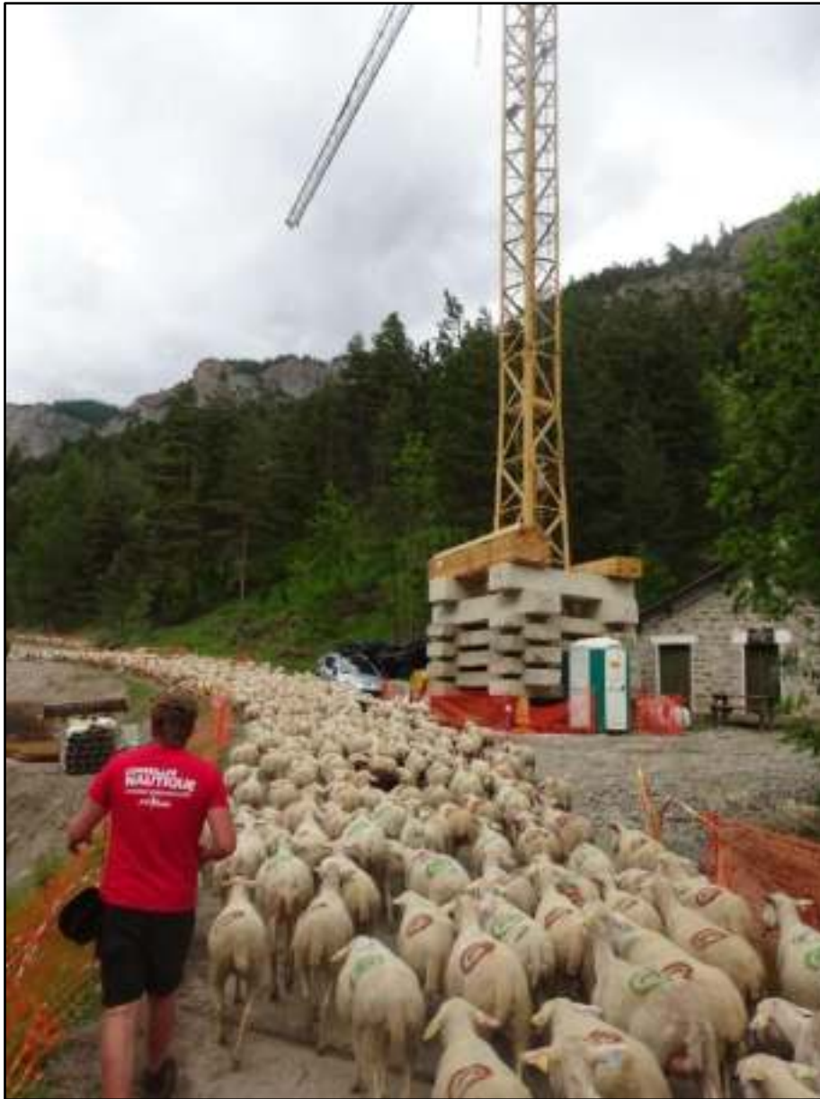
Image 40 : une centrale hydroélectrique en construction
